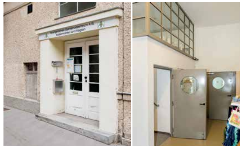
Links: der Eingang zum ehemaligen „Tröpferlbad“ – heute „Evangelisches Gemeindezentrum A.B.“. In der Mitte: der bis heute erhaltene Aufsichtsraum beim Eingang zum Bad. Auch die Zugangstüren zum Bad sind noch erhalten.
