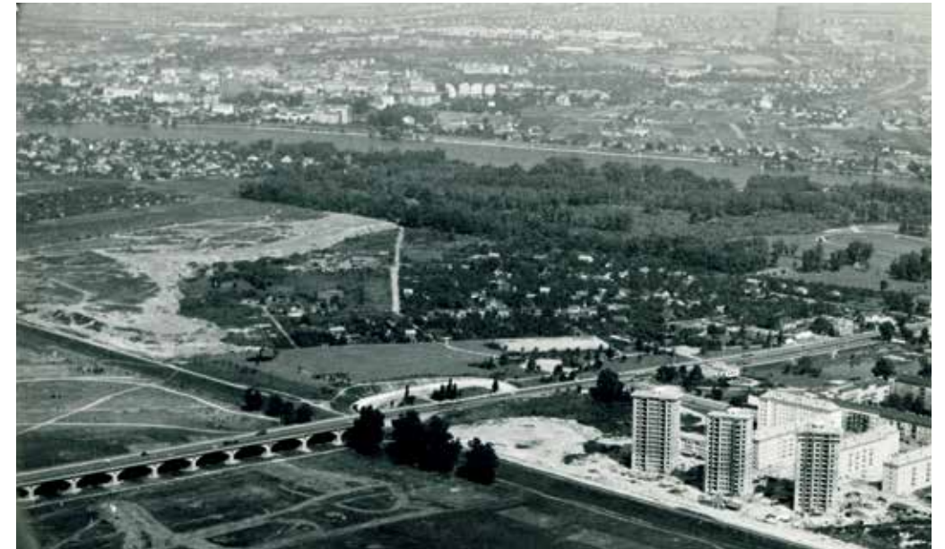
Im Hintergrund des Bildes ist das Gelände des heutigen Donauparks und der UNO-City zu sehen. Hier befanden sich die Mülldeponie und das „Bretteldorf“. Im Vordergrund liegen die drei Türme des damals im Bau befindlichen Marschall-Hofes. Bild um ca. 1959
