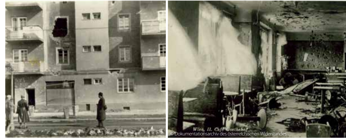
Zerstörungen am Goethehof von Februar 1934
