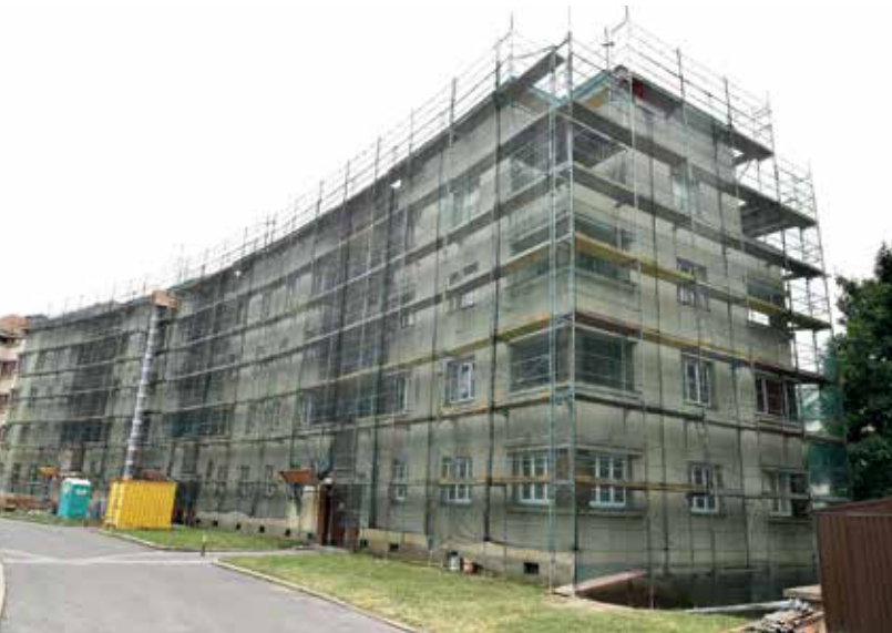
Goethehof während der Generalsanierung 2014
