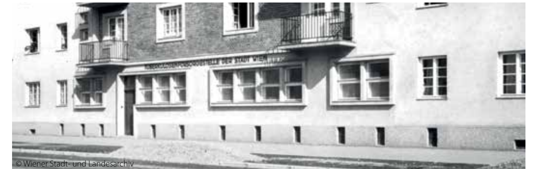
Die Tuberkulosefürsorgestelle der Stadt Wien in der Schüttaustraße.
